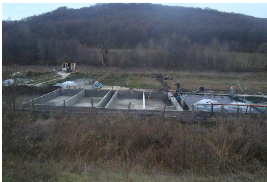
Рис. 3. Ділянка рибного господарства з бетонними ставами
