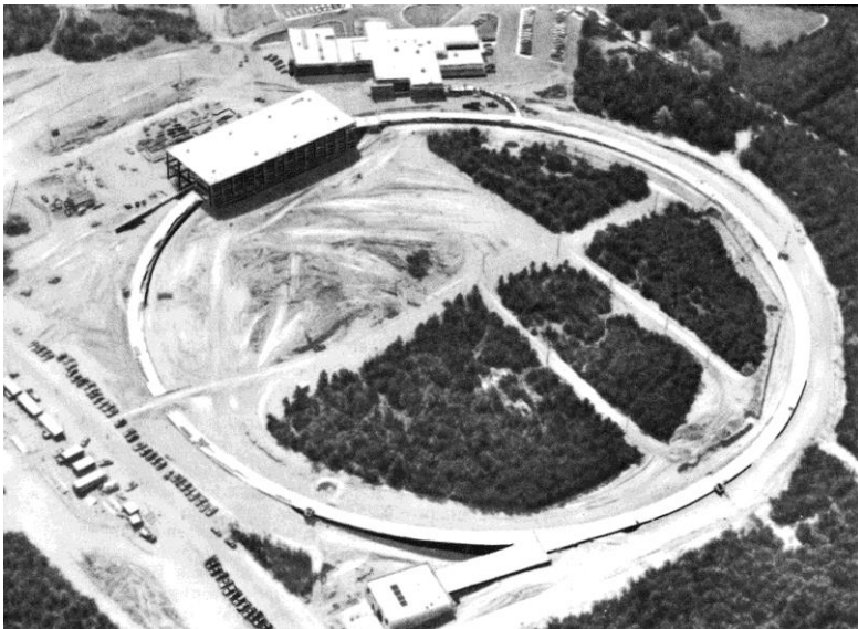
Брукхейєнський синхротрон на 30 БеВ. (Магніт довжиною майже в кілометр в кільцевому підземному тунелі)
