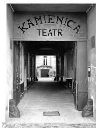
Fot. 3. Widok na bramę wejściową i fragment dziedzińca Teatru Kamienica po remoncie. [źródło: http://pl.wikipedia.org/wiki/Teatr_Kamienica ]
