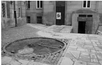
Fot. 22. Remont dziedzińca kamienicy. [źródło: http://teatrkamienica.pl/?page=5 .]
