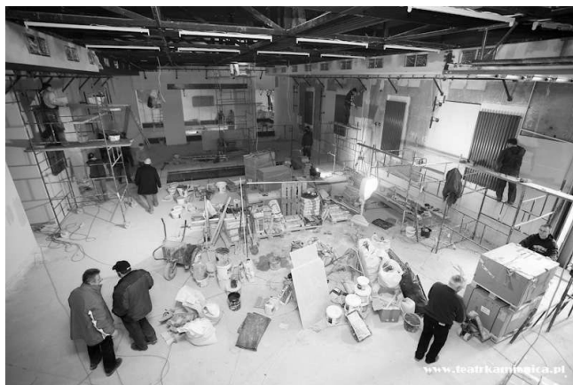
Fot. 2. Budowa Sceny Oficyna, w lewym dolnym rogu Emilian Kamiński nadzorujący remont.
