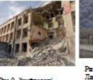
Рис. 9- Зруйнований будинок у місті Рубіжань (Фото https://youtu.be/SVbK4e5qH8k )
