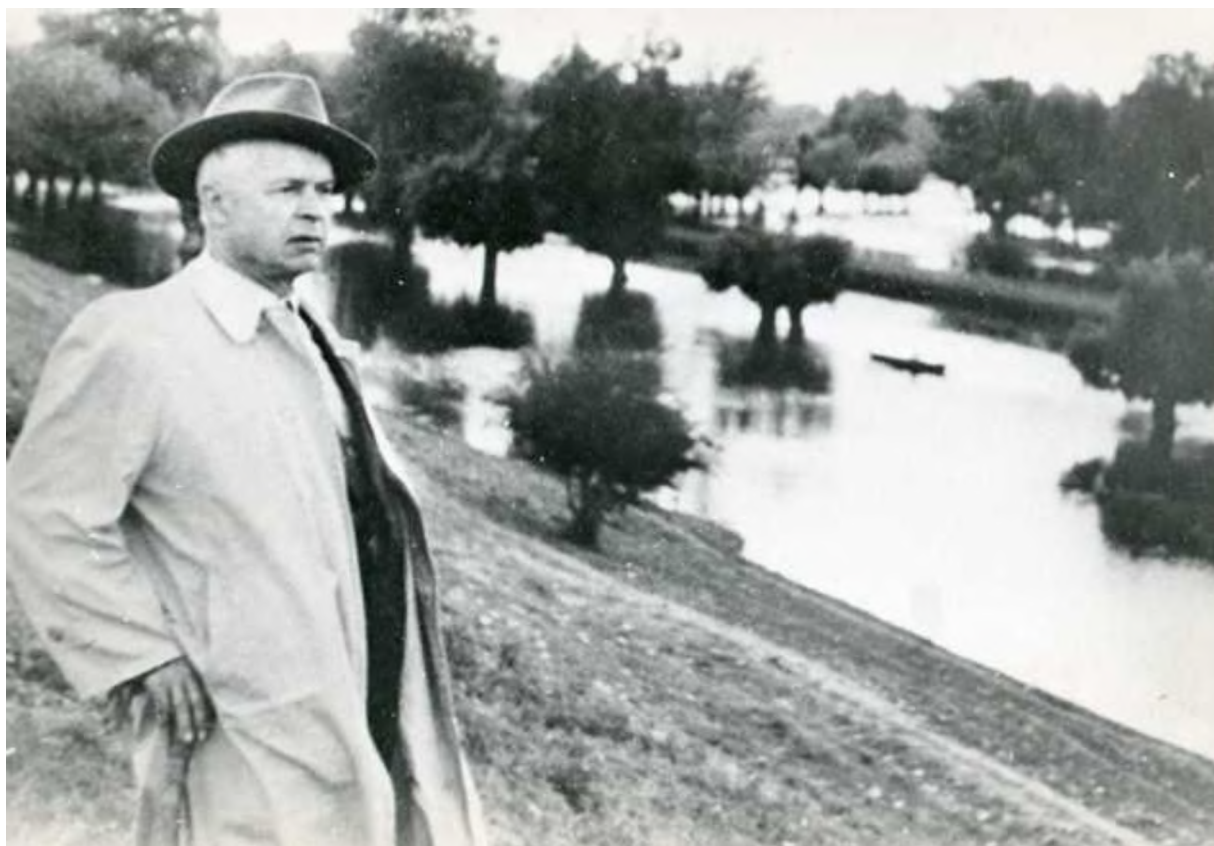
О. Довженко під час будівництва Каховської ГЕС.
