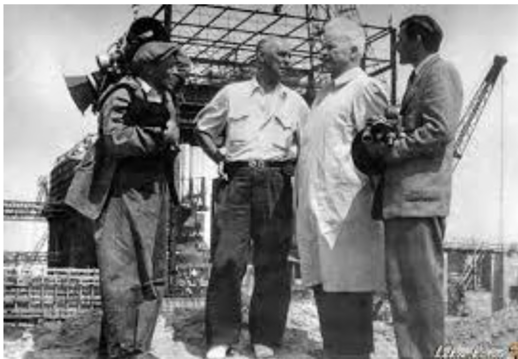
Довженко О. П. на будівництві Каховської ГЕС.
