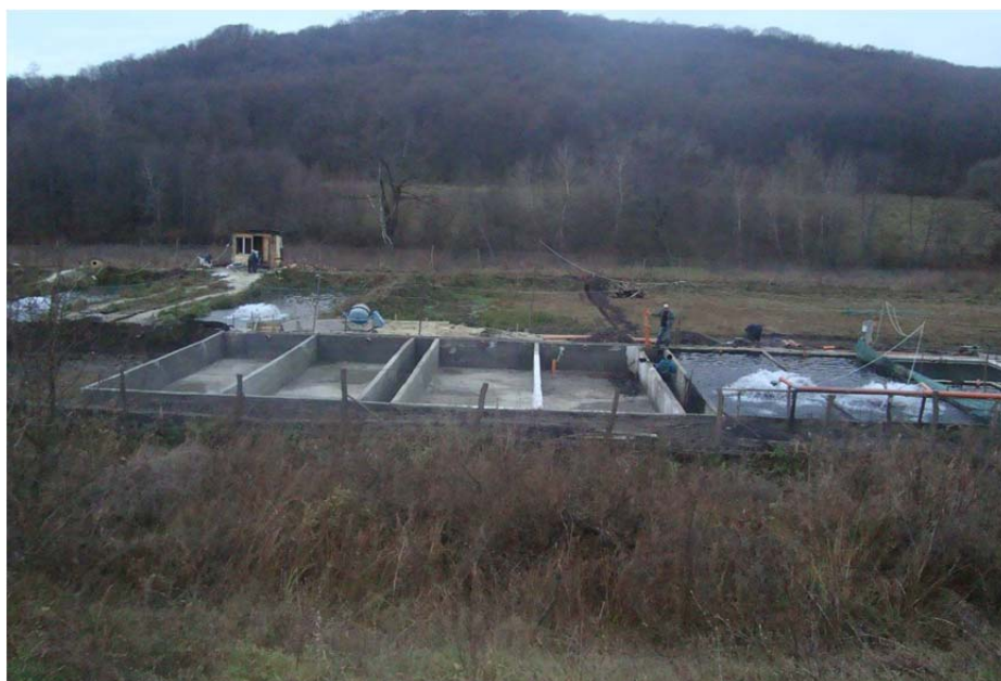
Рис. 3. Ділянка рибного господарства з бетонними ставами
